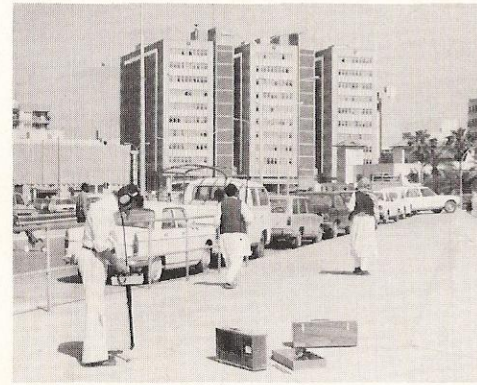
• اكتشاف اليكتروني لخدمات ما تحت الأرض قبل تركيب المعلم الأرضي Electronic detection of underground services before installation of ground marker.
