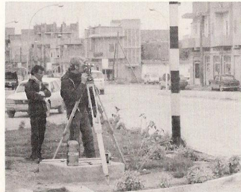
• تخطيط بالتقاطع ثلاثي على مستوى الشارع Tertiary traversing at street level.
