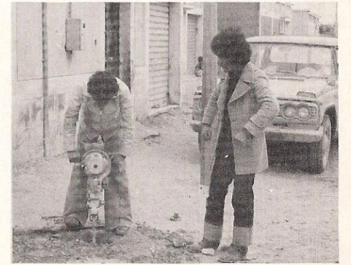
• تركيب المعلم الأرضي Installation of ground marker.
